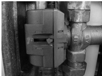
Aspiration eau de ville dans le disconnecteur
